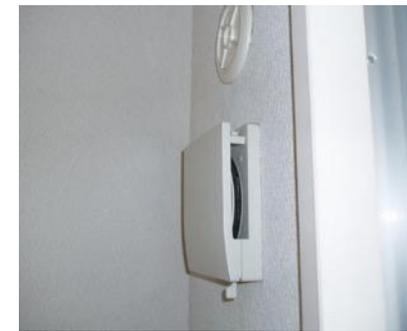
図1 24時間換気システムのスイッチの例
