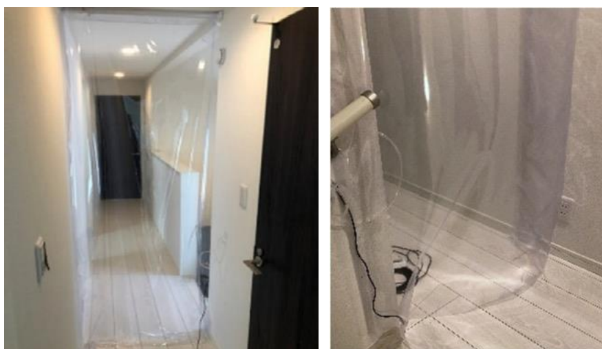
図8 ビニールシートによる間仕切り
