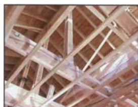
①天井部施工前（野縁を組んだ状態）。
