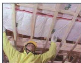
②断熱材を施工、すき間ができないように突き付けます。
