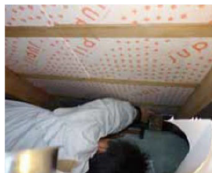
床下側から施工の様子
