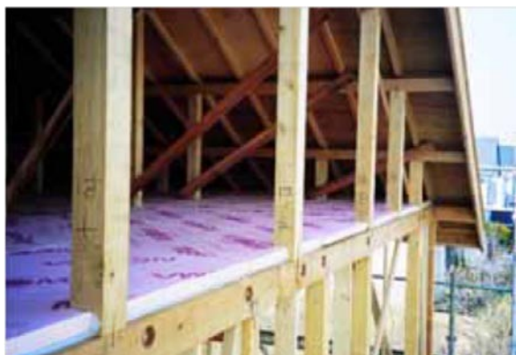
桁上断熱工法の納まり
